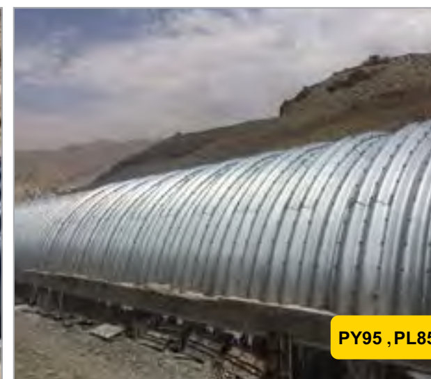
کوتینگ پل‌های قوسی گالوانیزه
